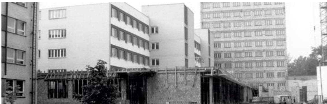
Teren budowy kliniki 1998 r.
