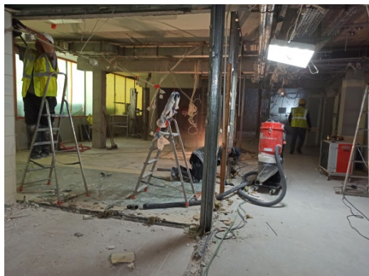
Początek prac remontowych, wrzesień 2023
