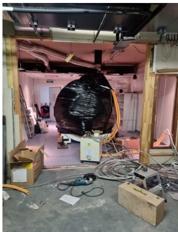
Demontaż starego urządzenia
