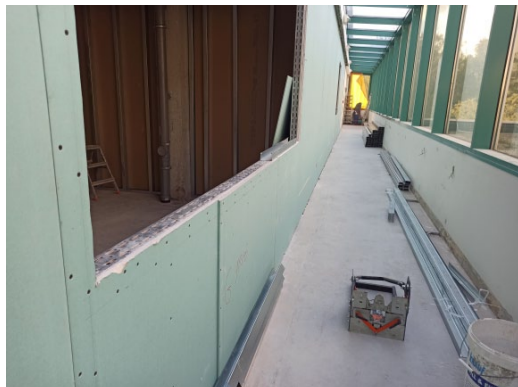
Korytarz przy bloku operacyjnym, październik 2023
