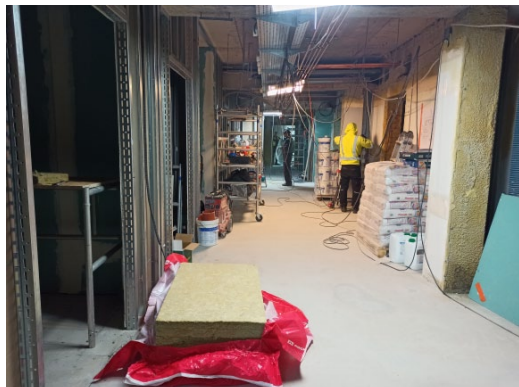
Montaż nowej instalacji
